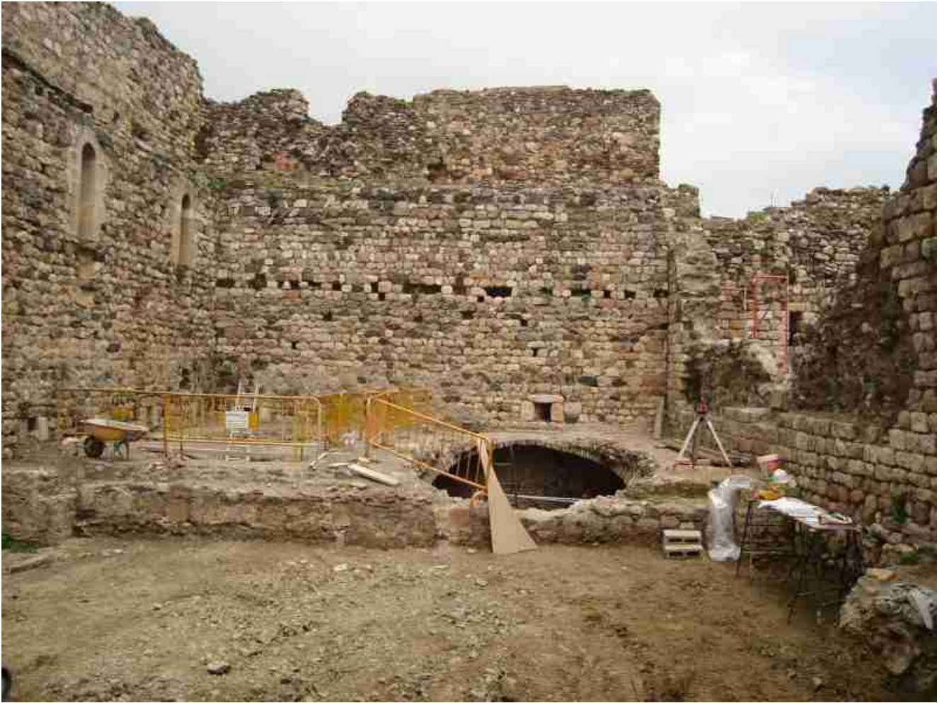
El Celler Major, abans de les obres.
